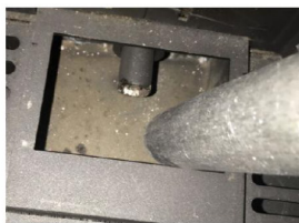
Después de limpiar
